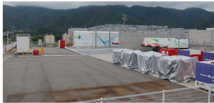
図14 水素出荷施設のカードルなどの保管場所
