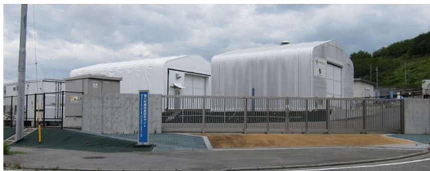
図12 電力貯蔵技術研究サイト
