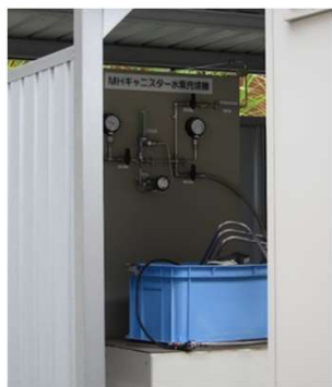
図11 水素吸蔵合金キャニスターへの水素充填設備
