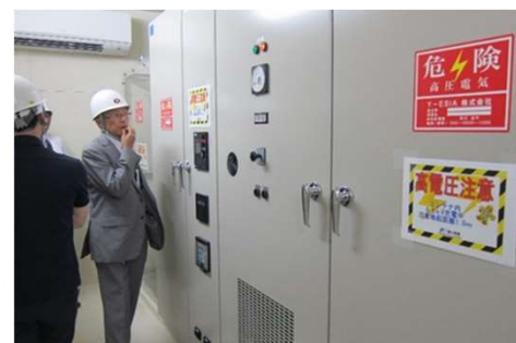
図25 コンテナに収められた受配電設備
