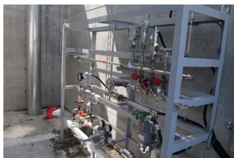
図21 水素トレーラーの水素を受け入れるための設備
