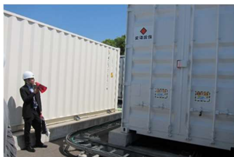
図25 コンテナに収められた受配電設備
