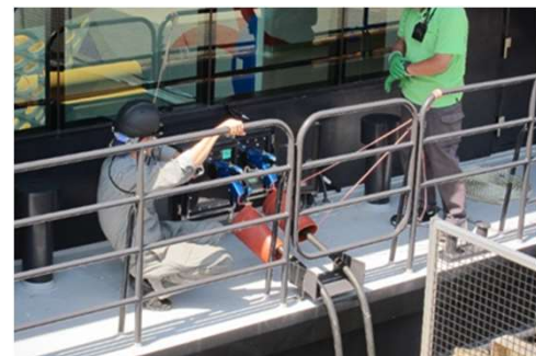
図18 “まほろば”に搭載された蓄電池を充電するためにバンカリング施設岸壁から延ばされた2本のケーブル
