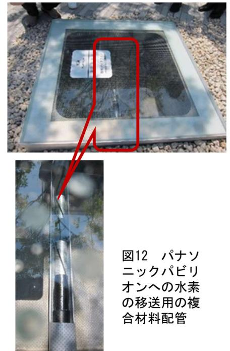
図12 パナソニックパビリオンへの水素の移送用の複合材料配管
