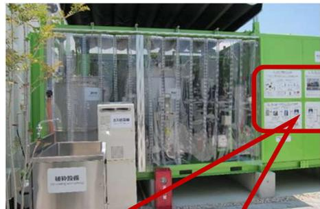
水素関連設備については、NTTアノードエナジー担当者から詳細な説明がありました（図10）。NTTパビリオン屋上に設置されたフィルム型ペロブスカイト太陽電池（東芝エネルギーシステムズからの提供品）から、図11に示すテナ内部のパワーコンディショナーに送電され、AEM型水電解水素発生装置によって水素が製造されていました。この水電解水素発生装置はEnapter社製で、エノア社の統合ソフト「Hydro Manager」で制御されているようでした。製造された水素の一部はこのテナ内のパナソニック社製純水素型燃料電池（5kW）に送られて、発電された電気はパビリオンの照明などに利用されていました。残りの水素は、清水建設のHydro Q-Bic Lite、水素吸蔵合金タンクに蓄えられるとともに、敷設されたパイプラインを通してパナソニックパビリオンにまで約200m移送されています。
