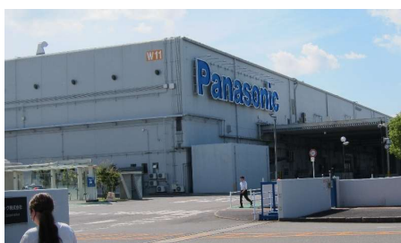
図5 Panasonic草津工場の燃料電池工場
