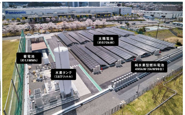
図6 “H2 KIBOU FIELD”における設備の配置 ( https://makenew.panasonic.jp/magazine/articles/010/ )
