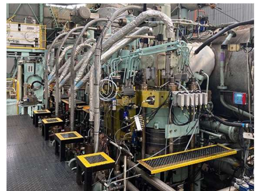
図10 三井E&Sの大型船舶用エンジンでの水素燃焼テストの状況
