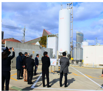
図6 神戸CGSスマートコミュニティ発電実証施設の川崎重工業製水素ガスタービン発電機(左)、液化水素タンク(中)、説明パネル(右)
