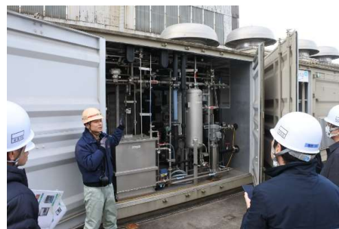
図18 オンサイト型水電解水素発生装置「ハイドロスプリング」
