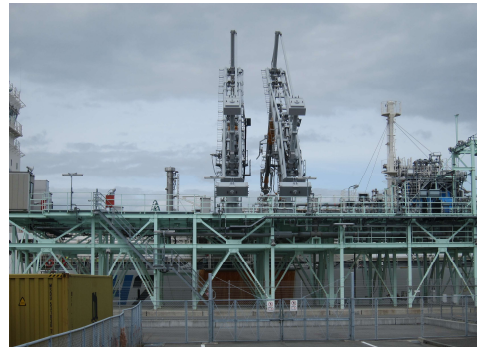
図4 フレキシブルホース式ローディングアームシステム
