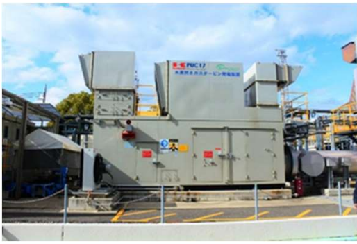
図6 神戸CGSスマートコミュニティ発電実証施設の川崎重工業製水素ガスタービン発電機(左)、液化水素タンク(中)、説明パネル(右)
