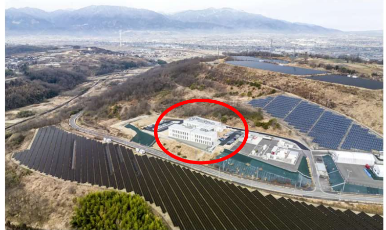
図1 山梨県甲府市の米倉山の写真（赤の○で囲む施設が新しく建設されました。）
