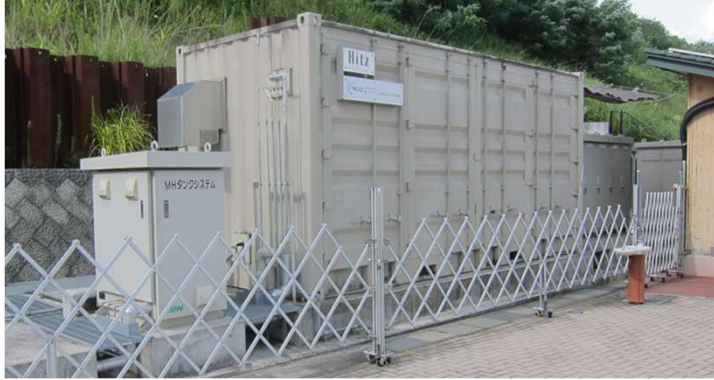
図5 太陽光で発電した電力で水を製造し、水素吸蔵合金に蓄える研究を行うための次世代Power to Gasシステム実証試験施設 (図8の⑤)
