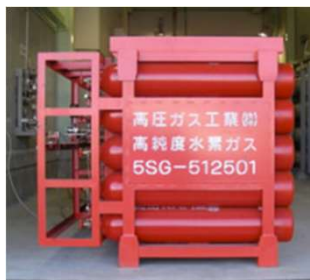
図2 高圧水素カードル https://www.koatsugas.co.jp/product/gas/industrial04/
