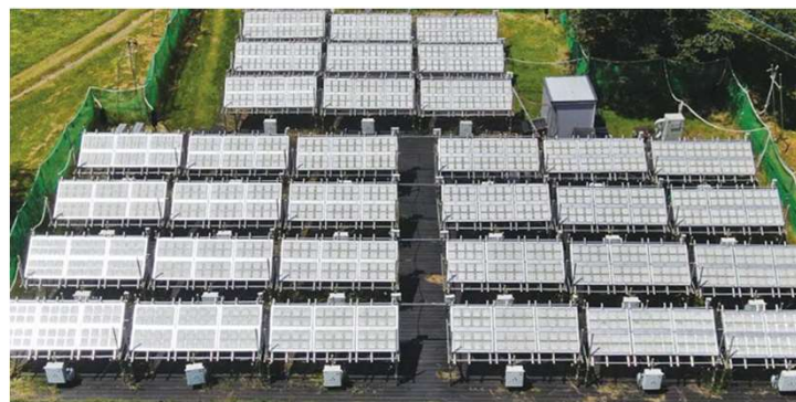
図4 100m 2 規模のソーラー水素製造パネル
