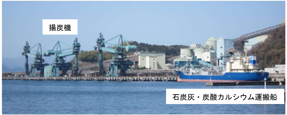
図1 舞鶴火力発電所の揚炭機などが設置された棧橋
