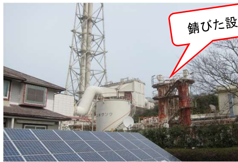
図8 太陽光発電設備・ソーラーハウスと、赤く錆びた設備
